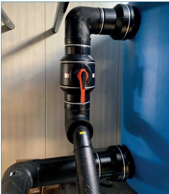
COOL-FIT 4.0 aansluiting op buffervat
