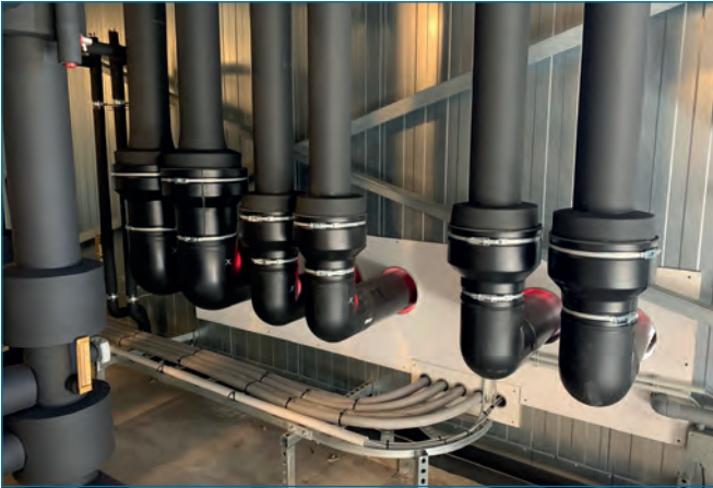
COOL-FIT 4.0 overgang naar staal
